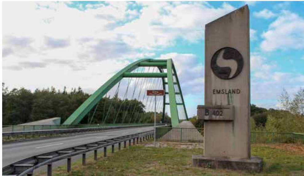
Die E 233 soll vierspurig ausgebaut werden. Foto: Landvolk.
